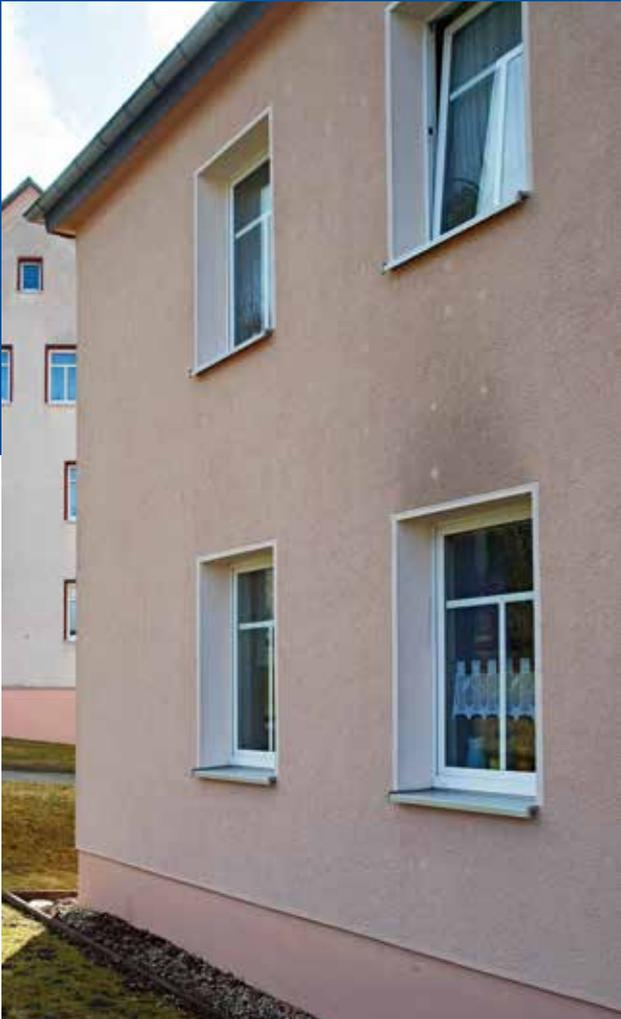
Fehlender Fassadenschutz: Dübelabzeichnungen fielen als helle Flecken insbesondere in den Bereichen mit starker Veralgung unangenehm auf. Dies ist nicht nur eine optische Misere, sondern schadet auf Dauer auch der Außenwand.
